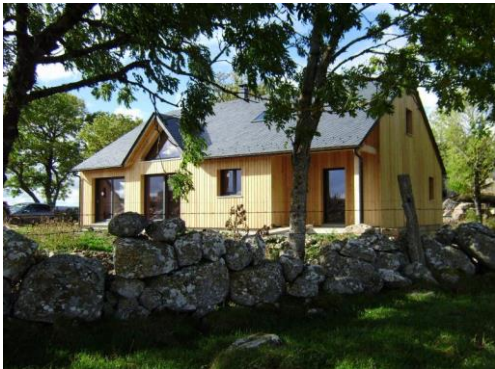
Maison à NASBINALS (48) - SARL ORLHAC (48)
